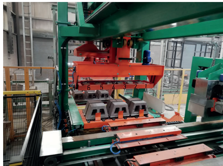
Área de desmolde
