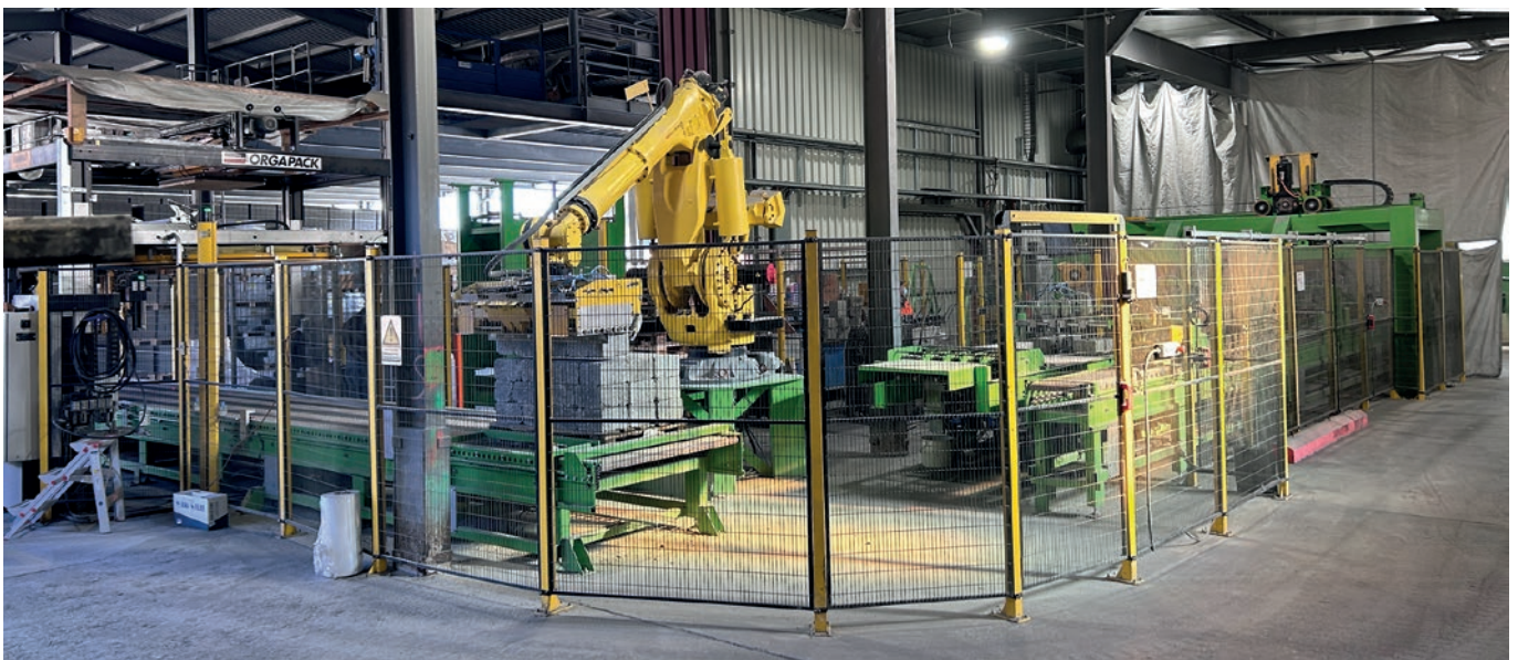
Blick auf die Sortier- und Paketieranlage von Penta
